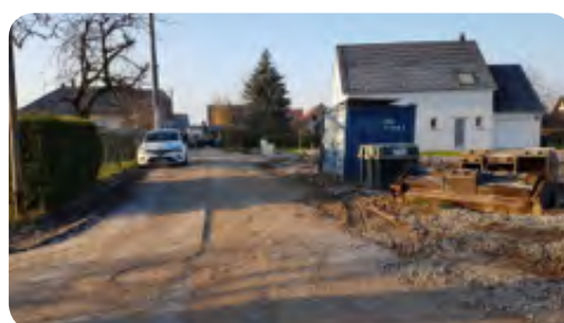
Travaux rue Belle Vue (M.V.)
