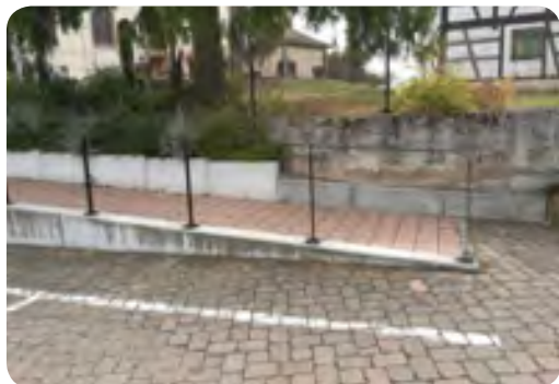
Rambarde de l'accès PMR au cimetière (E.R.)
