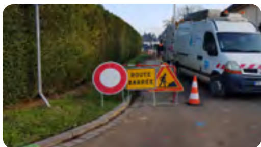
Les travaux de voirie ont commencé par l'intervention du SDEA (M.V.)
