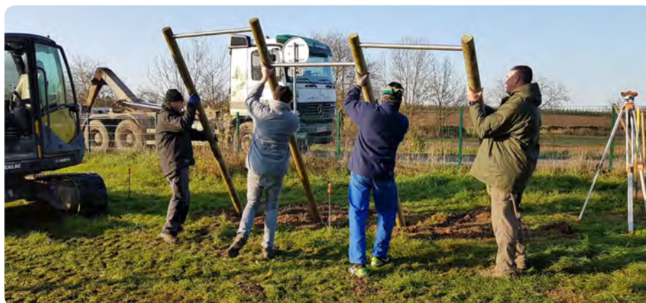
Installation des barres fixes
