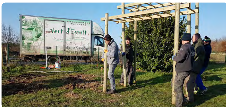
Installation de l'échelle de suspension
